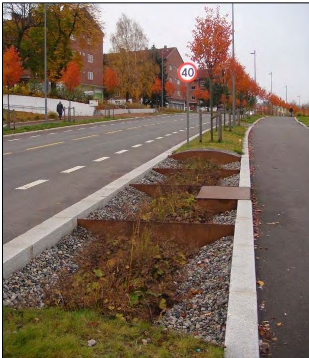
Figur 23. Biofilterdike mellan körbana och GC-bana i Ensjö, Norge. Foto Emma Nilsson Keskitalo
